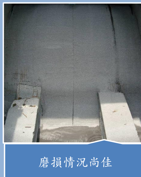
碳纖維混凝土修復大面積乾縮裂縫
