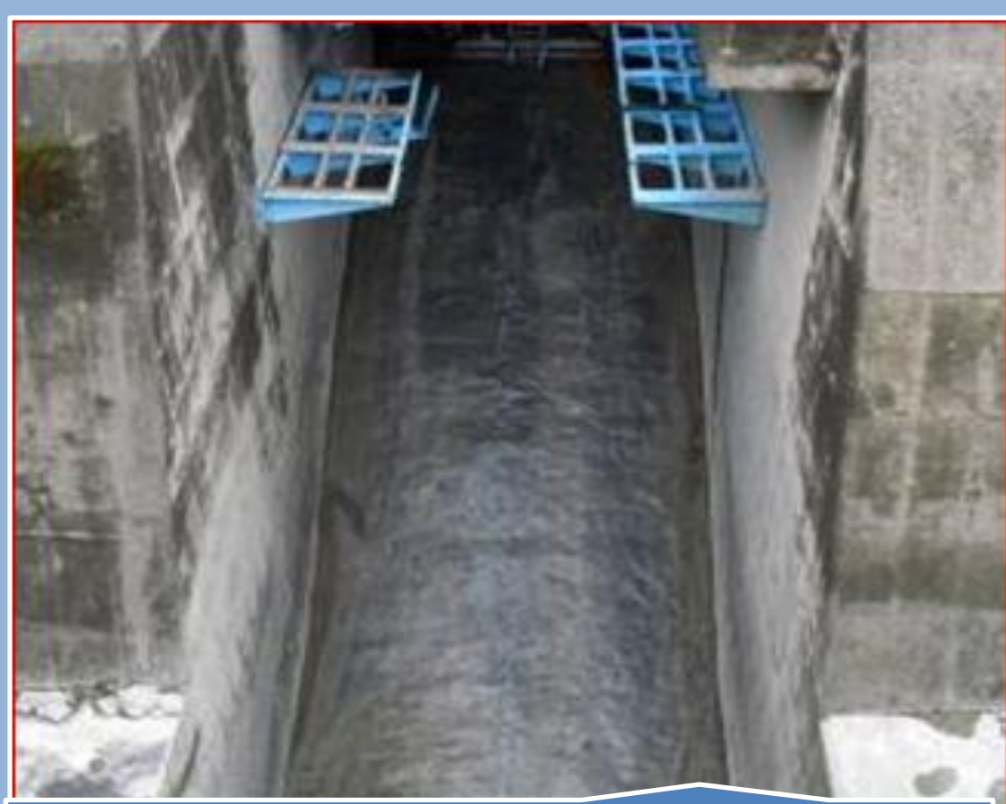
砂灰混凝土修復完成圖
