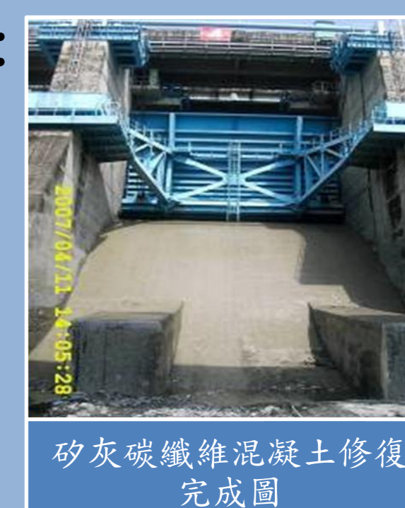
碳纖維混凝土修復大面積乾縮裂縫
