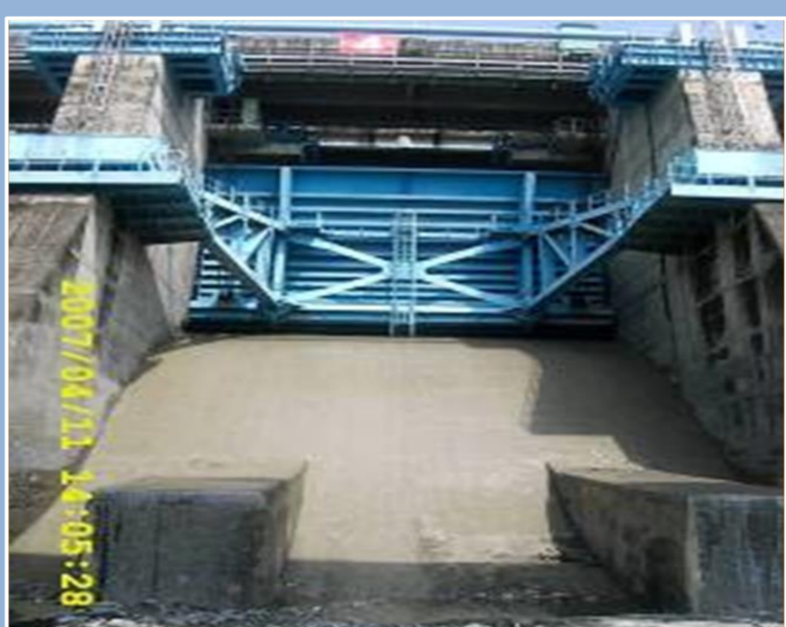
碳纖維混凝土施作完成圖
