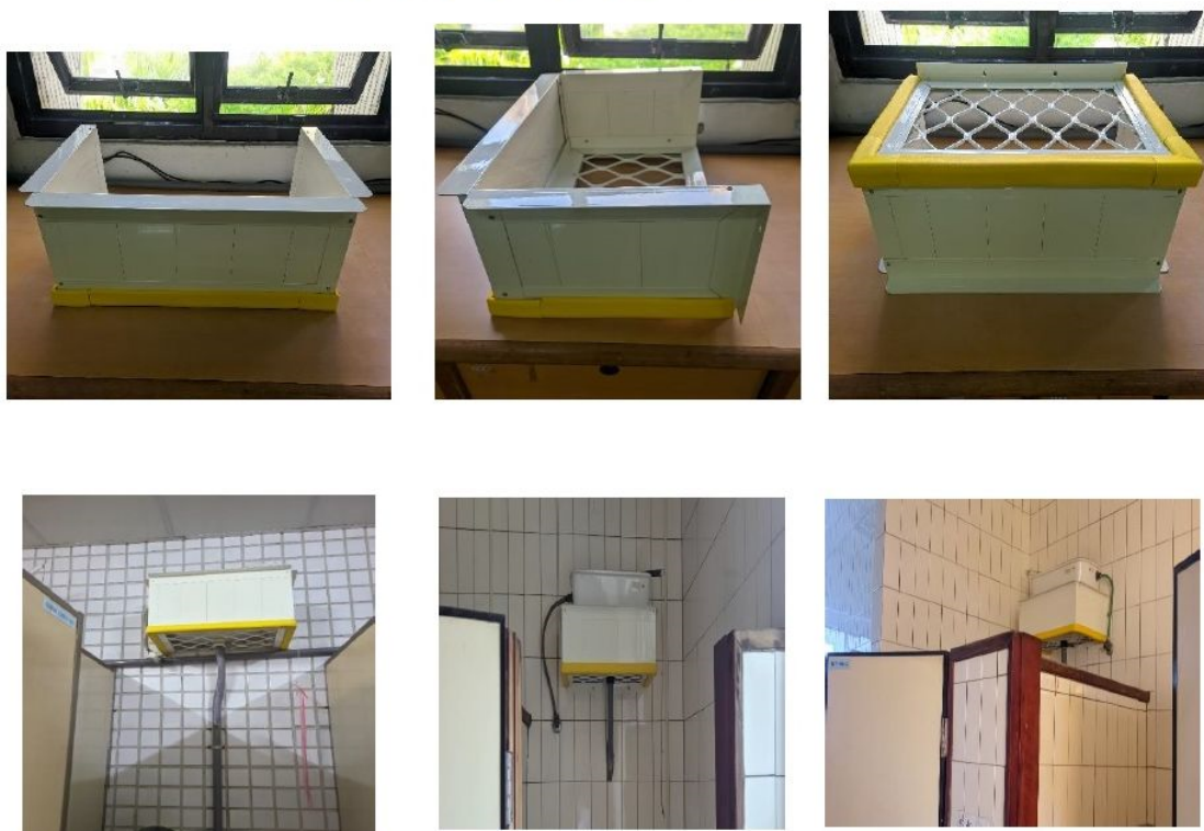
舊式廁所拉霸式水箱改善情形
