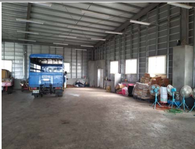
圖 5.貨車直接開入包裝集貨場，輪胎上的泥巴或塵土經影響場域及設備的衛生
