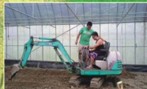
學生實習-設施內小怪手整地
