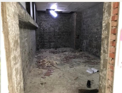
森林館第二棟無障礙廁所
