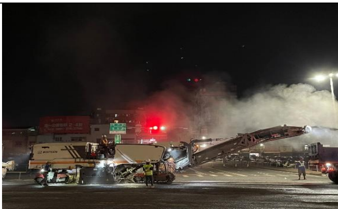
參訪實際路面鋪設
