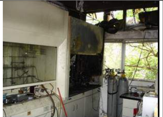
圖 2、災害現場燒毀之抽氣櫃(二)
