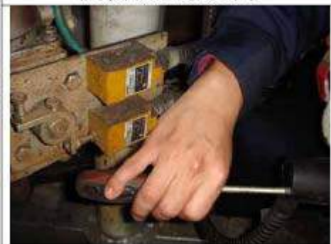
徒手拆解熱感知器外蓋螺絲(模擬)
