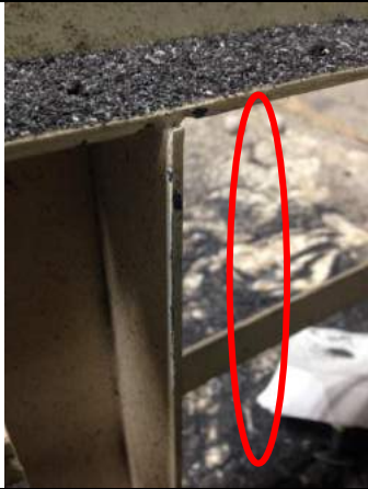
5-角鐵框架左側碰撞擦痕
