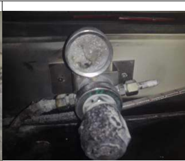
圖 2.瓦斯管路接頭纏有止水帶，更易鬆脫
