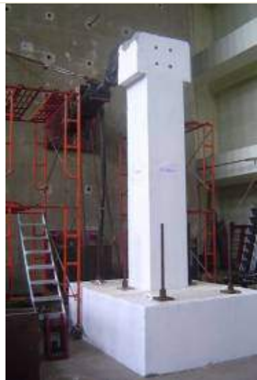
施工架內爬梯不完整
