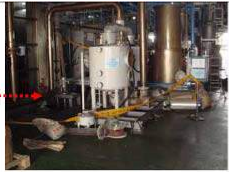
設備及人員位置
