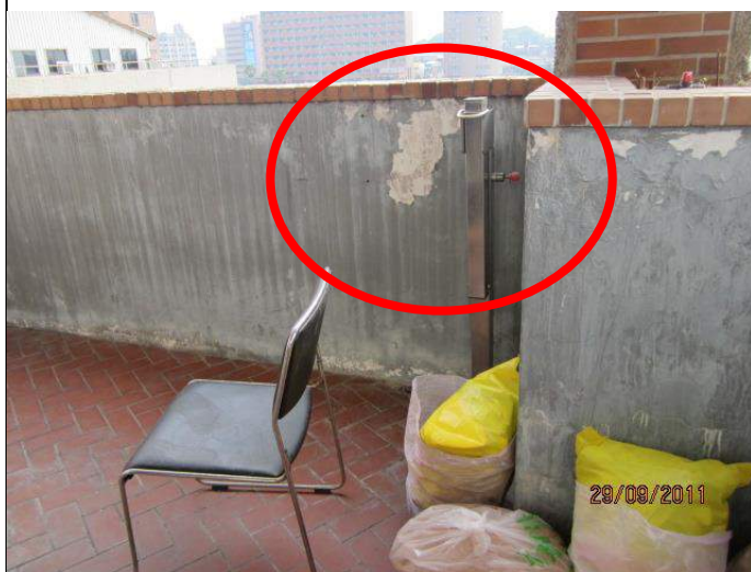
圖 9、逃生設備應定期確認維護(缺緩降機)
