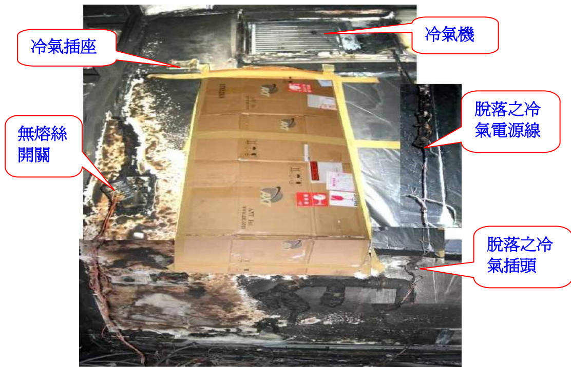
圖一 內牆電氣線路配置情形
