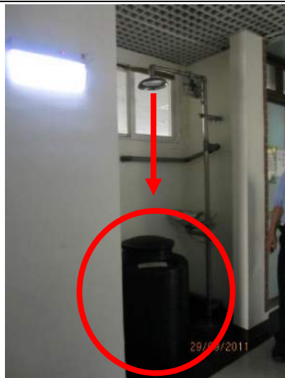
圖 7、實驗室外緊急沖淋設備位置堆放物品
