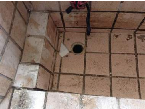
未經評估作業方法與危害，以固體苛性鈉倒入進水口，試圖疏通水管。
