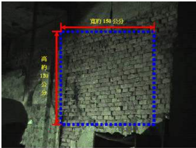
圖 1 發生倒塌事故的化學儲裝木櫃位置牆壁
