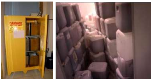
圖十五 (左) 廢液庫房內須確保有足夠空間，安放合格之廢液櫃，並設有不鏽鋼材質的盛載桶，以防止塑膠廢液桶因破裂而造成污染。(右) 不良的廢液暫存庫房例子。塑膠廢液桶可能因重力壓迫而破裂造成污染，嚴重時可能引發中毒或火災。
