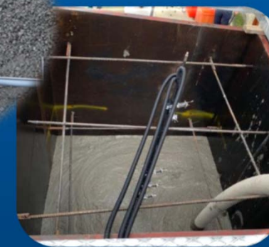
巨積混凝土現場施工與 溫度即時監測
