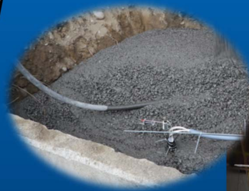
巨積混凝土現場施工與 溫度即時監測
