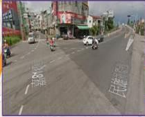
往民雄市區方向天橋
