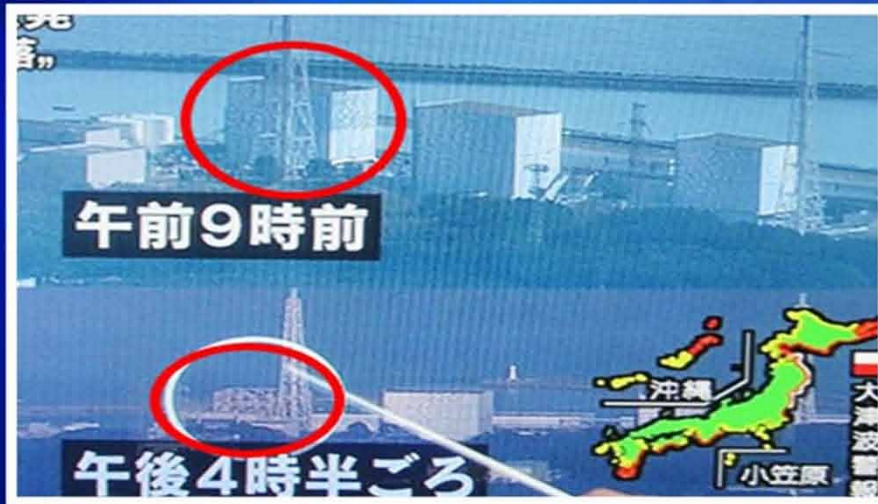
比較核電廠爆炸前後 一號機組外部建築只剩下鋼架
