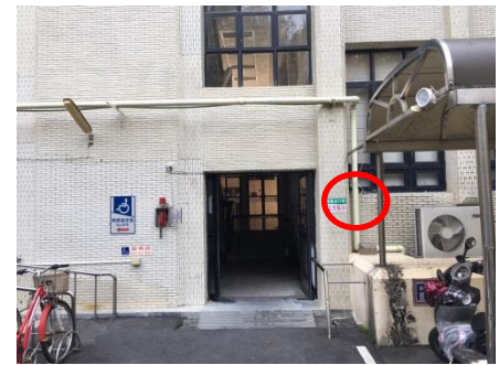
3. 行政中心側門一樓樓梯口
