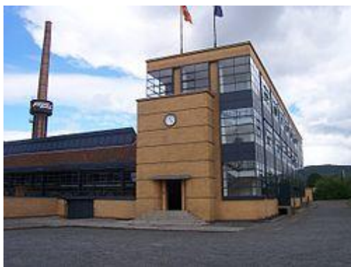
圖 4-17 法古斯鞋植工廠正側面玻璃帷幕窗牆
