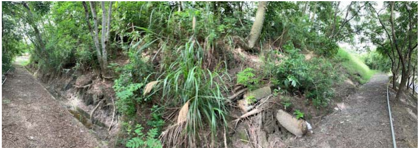
圖書館後方邊坡將堆置養殖池既有土包袋移至本區
