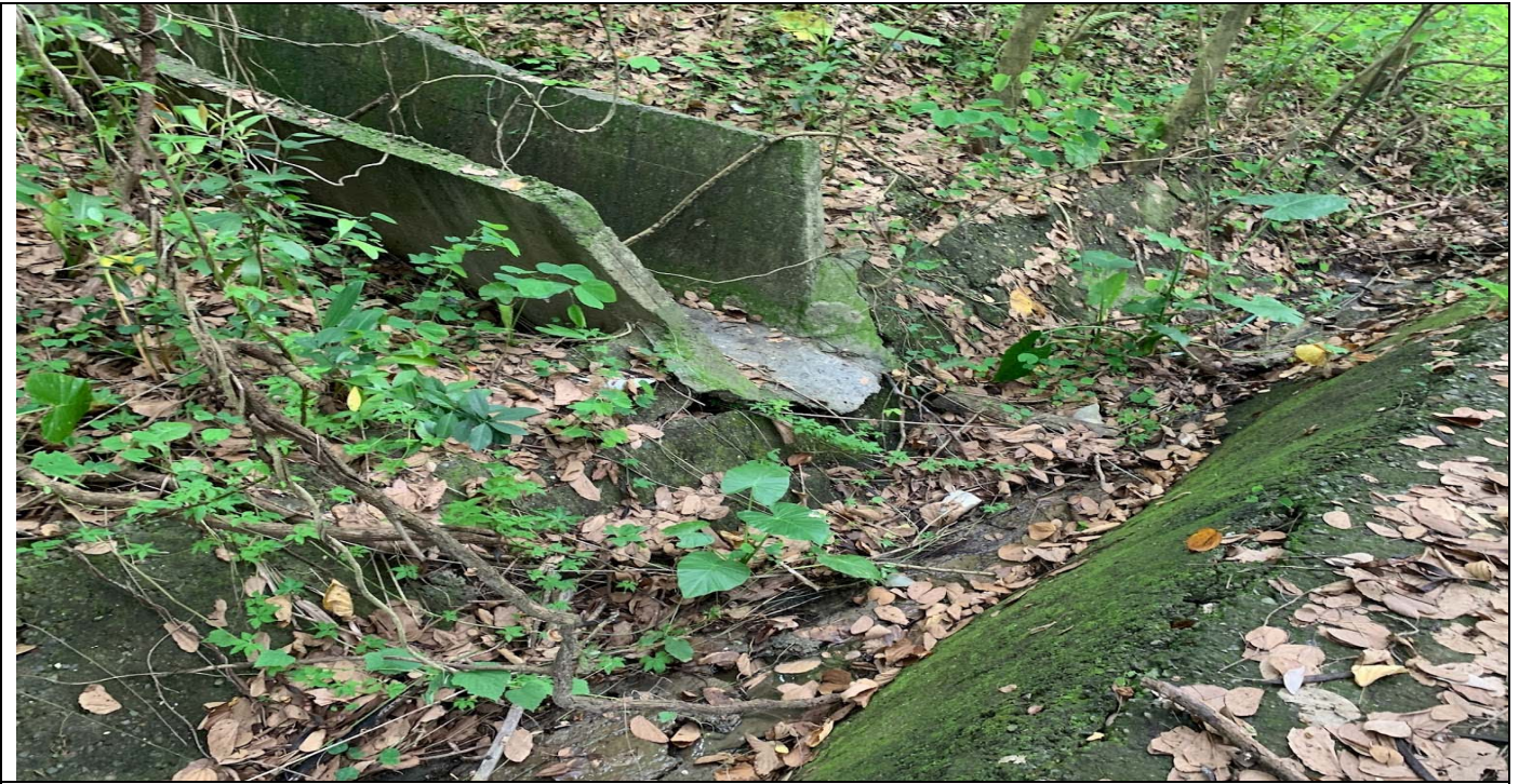
水生系館後方擋土牆排水系統
